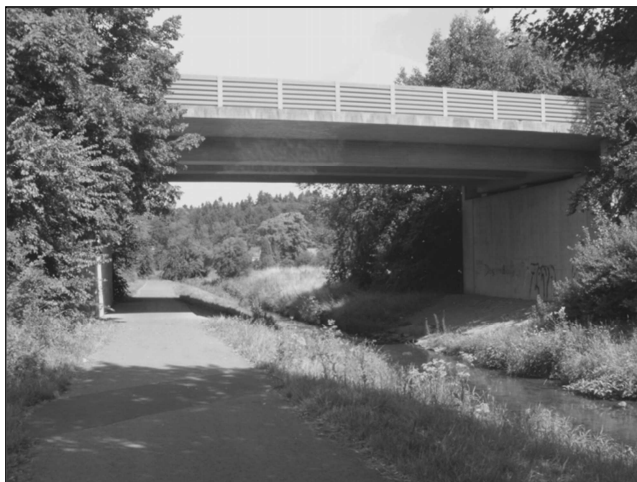
Swistbrücke, nördliche Überführung des Autoverkehrs
