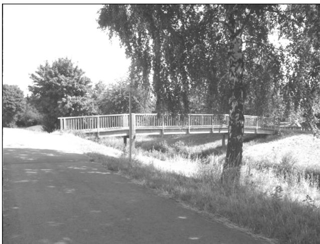
Holzbrücke an der Quellenstraße
