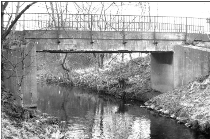
Alle Fotos: Archiv AK-Heimat Brücke über die Swist zur Burg Kriegshoven.
