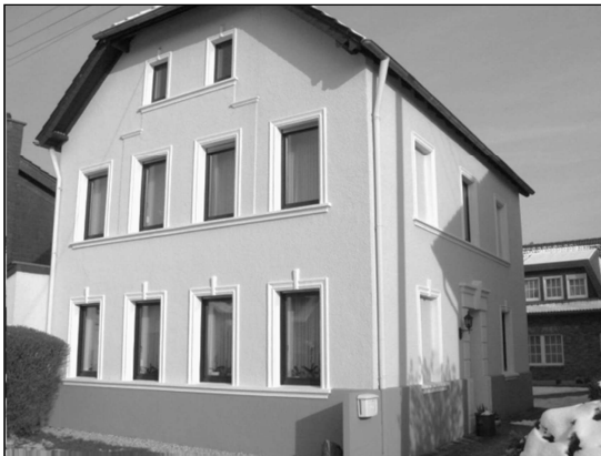
Haus Schäfer-Krewinkel an der Bachstraße, um 1920 erbaut. Rechts die zugemauerten Fenster
