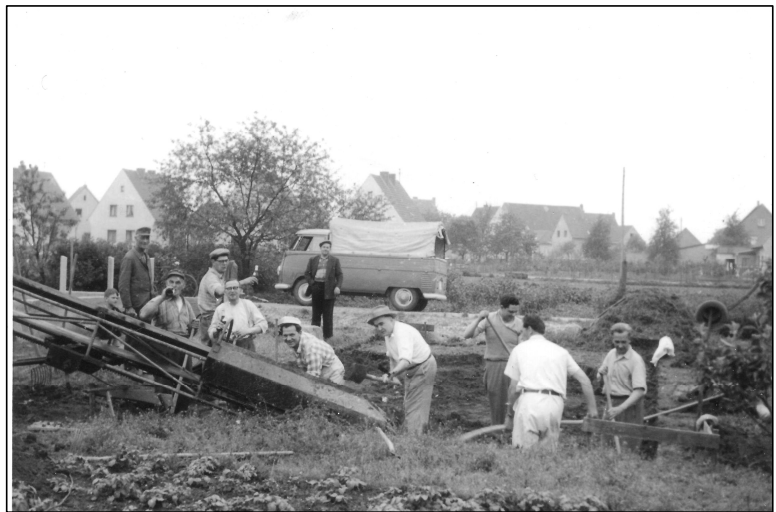
Baustelle Peter Euskirchen (Seemann); die Baugrube wurde noch per Hand aus- gehoben
