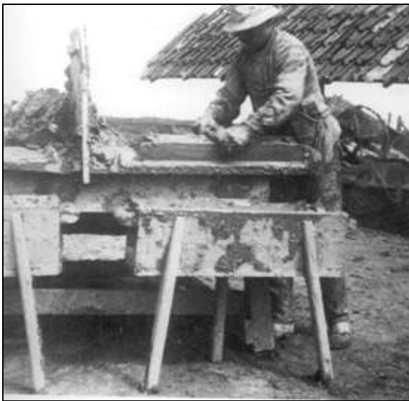
Der Lehm wird mit der Hand „ in Form gebracht“
